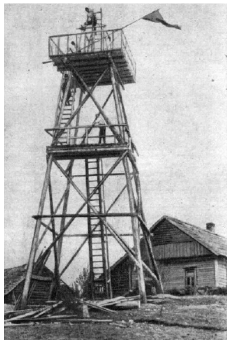
Рис. 3. Строительство пограничной наблюдательной вышки. 1930-е гг.
